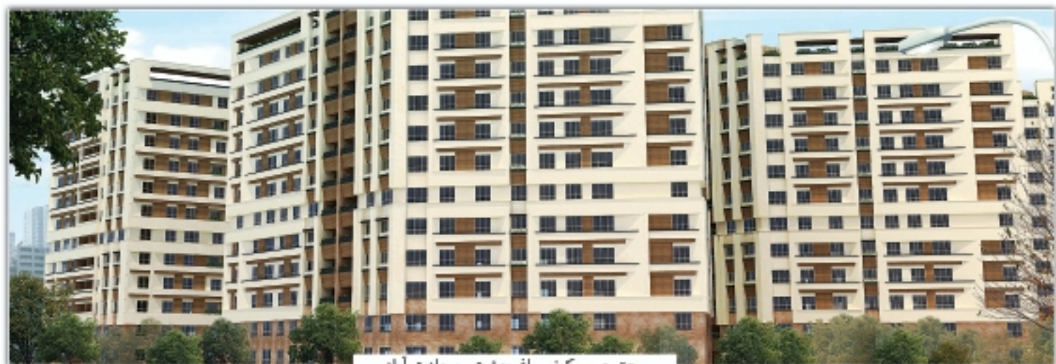
مجتمع مسکونی باغ بهشت - سعادت آباد
